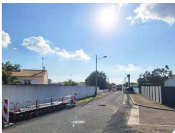
>Rue de la Traversée.
