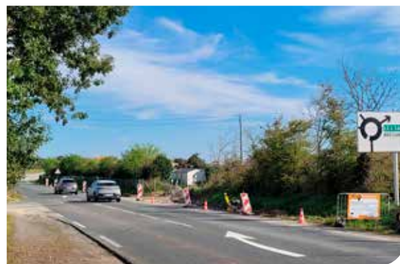
>Travaux réalisés du 30/09 au 25/10.
